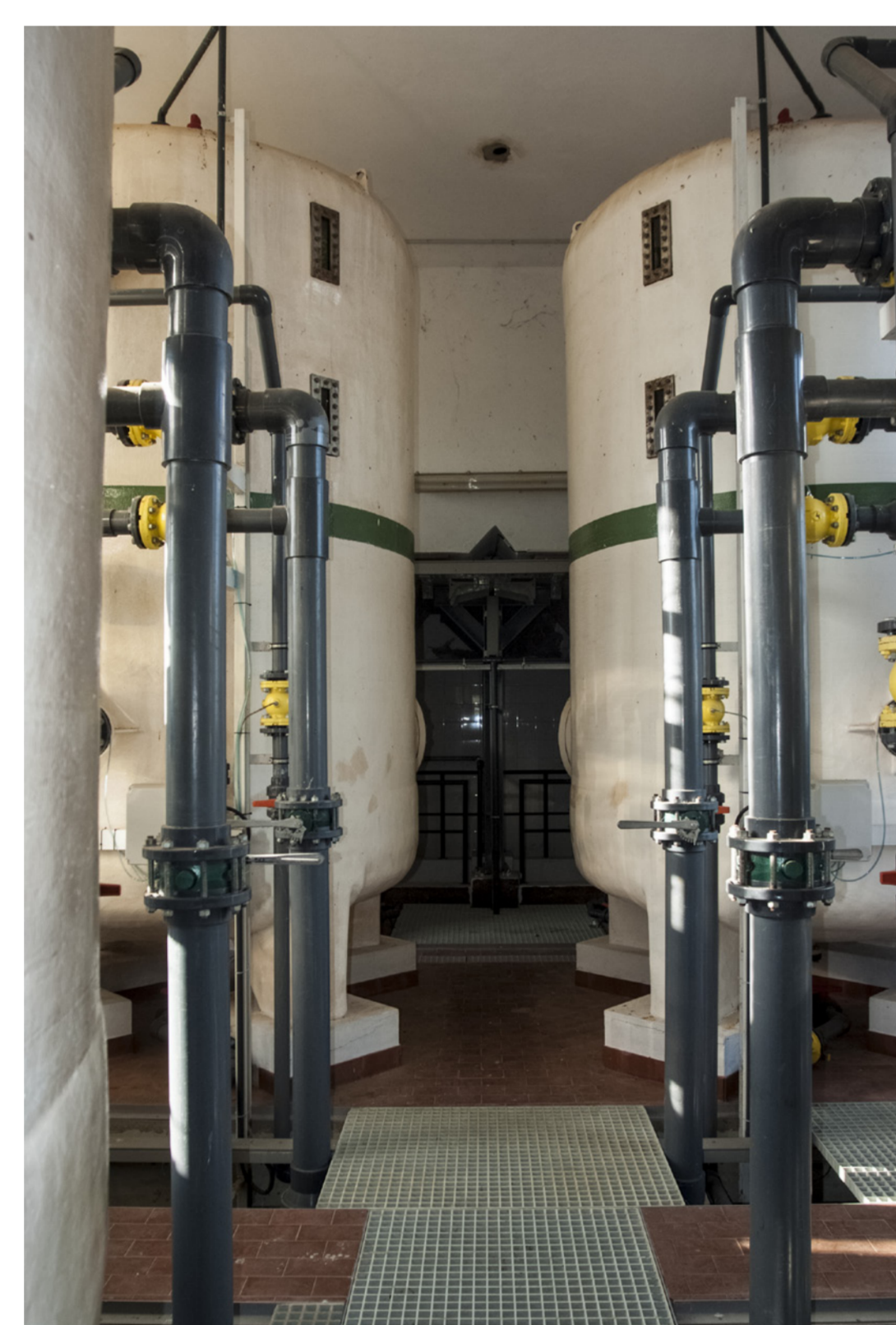
CAPTAÇÃO E DISTRIBUIÇÃO DE ÁGUA, NASCENTE DA FONTE DA TELHA
