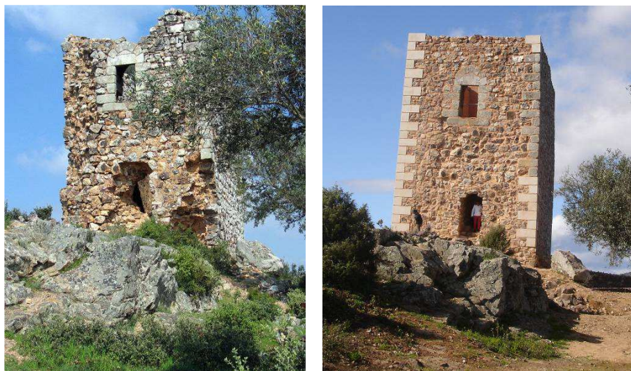
Figura 3. A torre do Castelo de Ródão, antes e depois do restauro.
