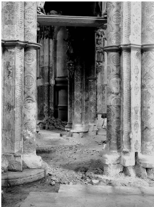
**Ilustração 29** - Degradação de pavimentos e colunas da Charola (DGEMN/DRMLisboa, IPPAR, Sem datação)
