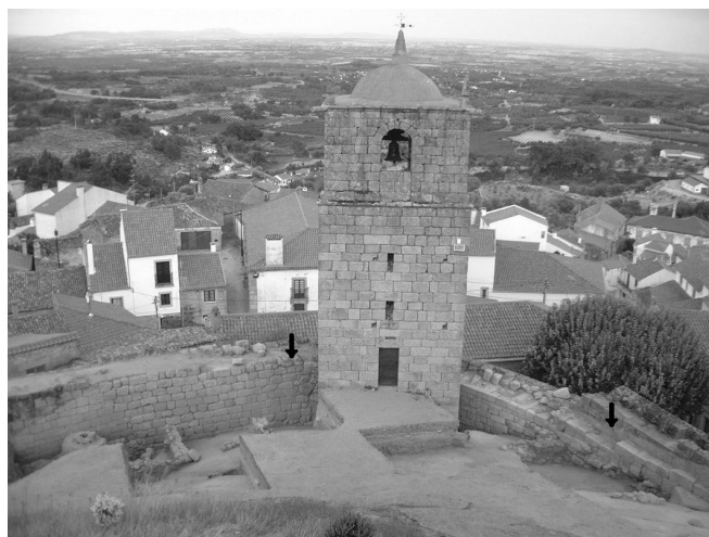
FIGURA 8. Sector Leste e Sul do castelo no final da segunda campanha, com a Torre do Relógio. Indica-se à esquerda o local onde a muralha da 2ª fase de ocupação está truncada para implantação desta torre. Indica-se à direita a sobreposição da muralha da 1ª fase por reconstrução sub-actual (foto AT).
