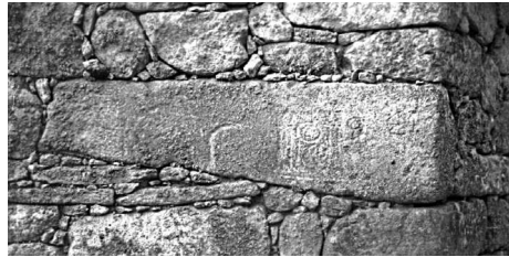
Fig. 35 – Localização da pedra gravada.
