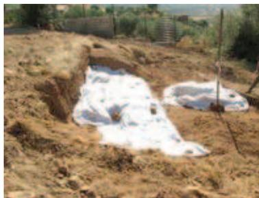
Fotografias 13. Cobertura da área de escavação com tela geotêxtil. Preparação para cobertura final e trabalhos de protecção das estruturas arqueológicas.
