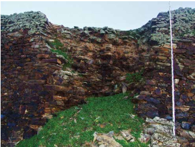
Figura 6. Zona 3 antes do início da reconstrução da muralha.
