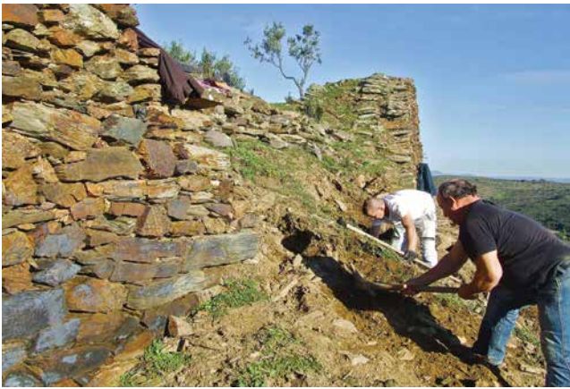
Figura 4. Trabalhos de escavação do derrube da muralha, no início da reconstrução da zona 6.
