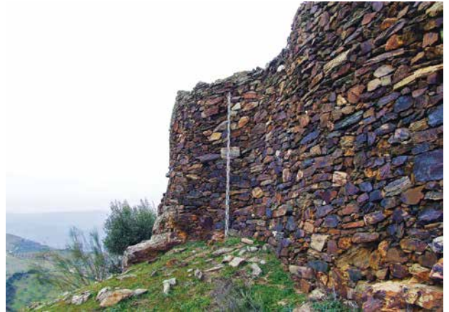
Figuras 12 e 13. Inflexões na muralha, de forma a ser conseguida sustentação nos maciços de rocha base.
