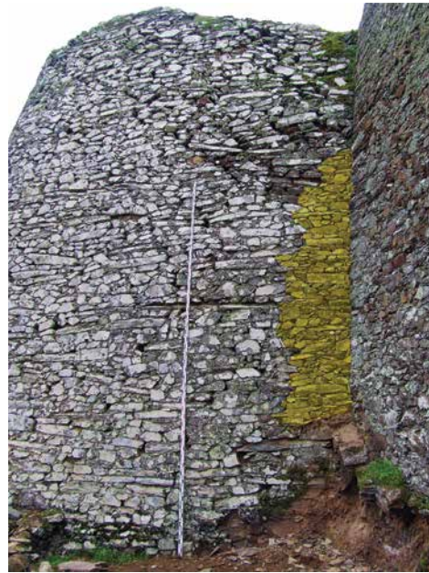
Figura 11. Zona 10 depois da reconstrução (assinalada a amarelo).
