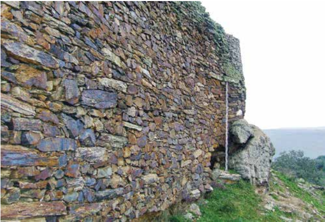
Figuras 12 e 13. Inflexões na muralha, de forma a ser conseguida sustentação nos maciços de rocha base.
