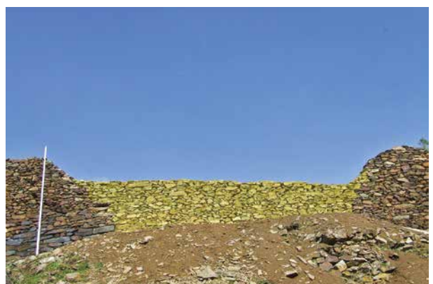
Figura 9. Zona 6 depois da reconstrução (assinalada a amarelo).
