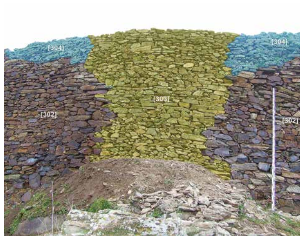
Figura 7. Zona 3 depois da reconstrução da muralha (assinalada com [302]). São também identificadas as reconstruções: a atual (assinalada com [303]) e a mais antiga (assinalada com [304]).
