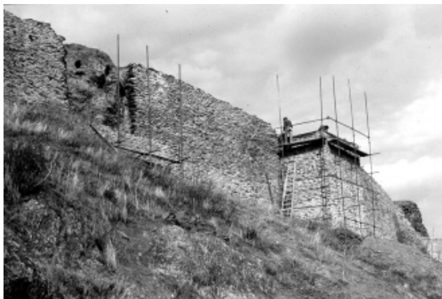
Pormenor do pano da eventual muralha islâmica, em taipa, coberta com alvenaria de xisto no século XIV
