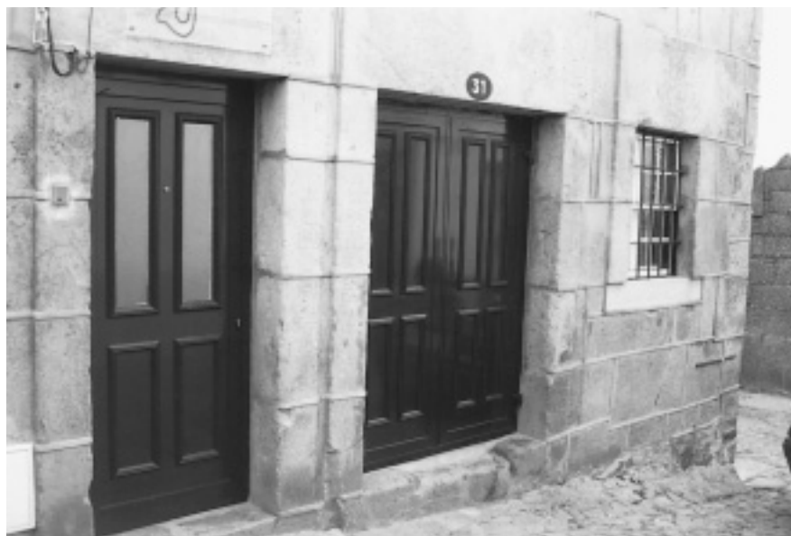
Fig. 9. Aspecto das portas de entrada da fachada principal do edifício, observando-se algumas gravações nas ombreiras entre as duas portas.
