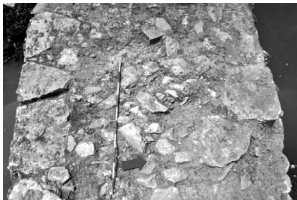
Fig. 17 – Corredoura: aparelho do tramo norte da muralha, em alvenaria de duas folhas, com enchimento de pedra miúda.
