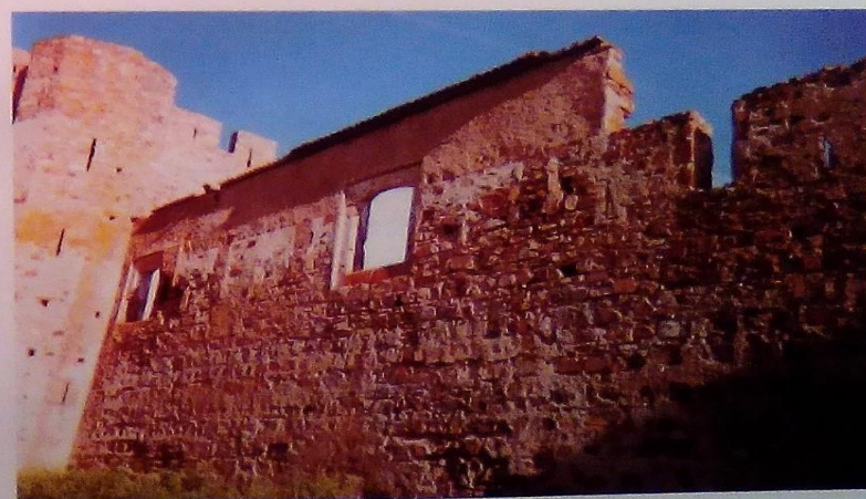
Fig.6 - Alçado norte da muralha onde se notam alterações do inicio do século XVI.
