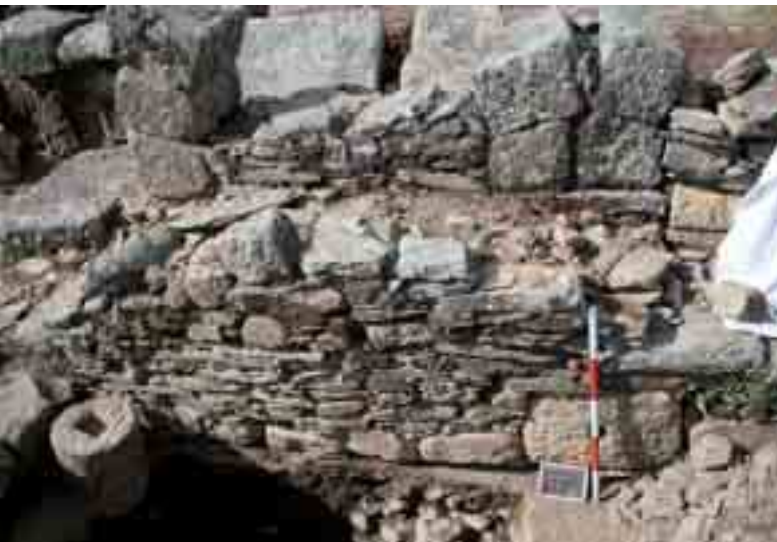
Fig. 108. Estructura de contención de lajas de pizarra adosada a la arquería de la nave central (SII/U.E.9).
