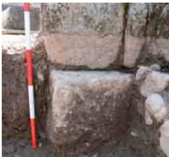
Fig. 119. Zona occidental del sondeo. Detalle de la cimentación del pilar U.E. 6 (SII/U.E.12).
