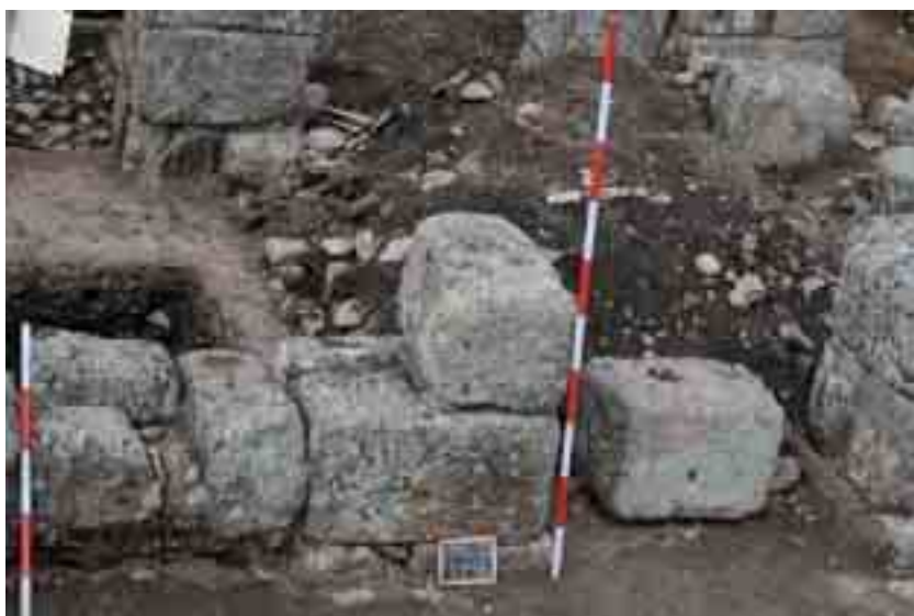
Fig. 66. Segundo pilar de la arquería de la nave lateral sur del edificio tardoantiguo (SI/U.E.7).
