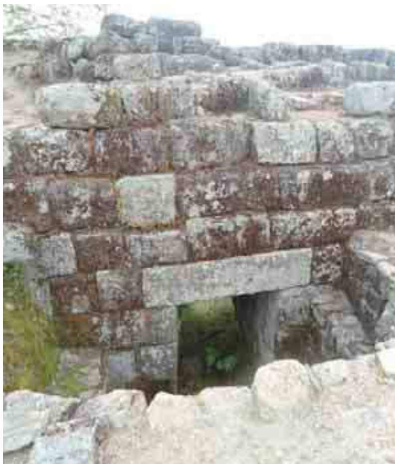
Fig. 10. Poterna o pequeño acceso abierto en el tramo meridional de la muralla.
