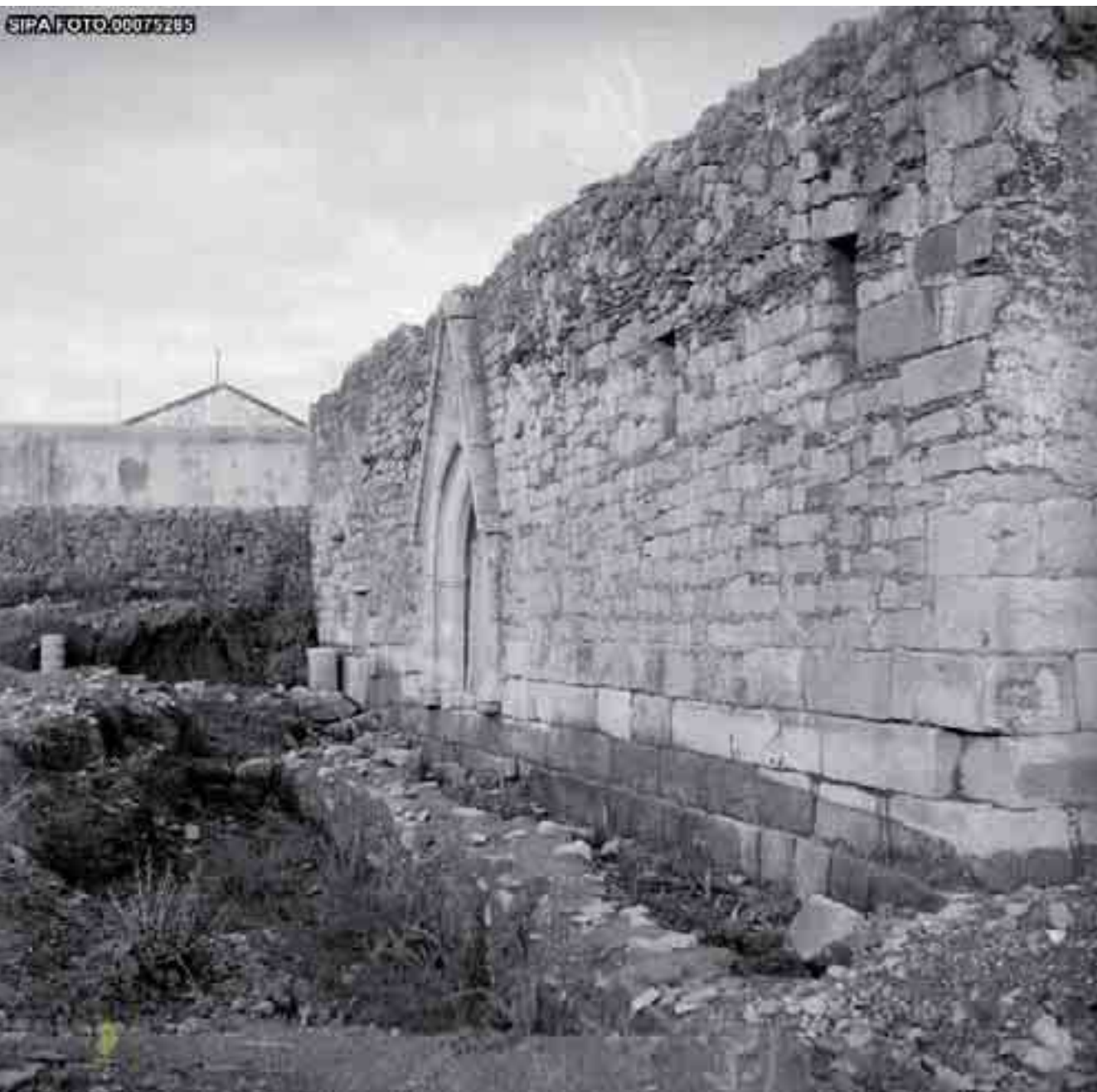
Fig. 22. Fachada de la iglesia en 1959 (©SIPA).
