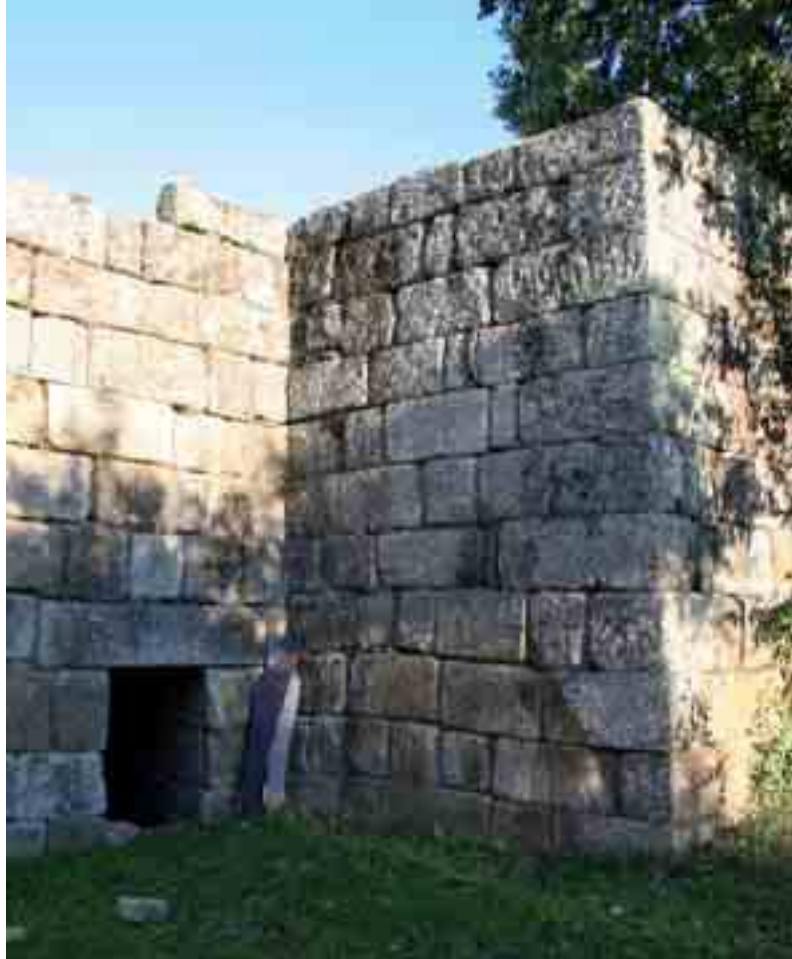
Fig. 9. Torre rectangular situada en el tramo meridional de la muralla.
