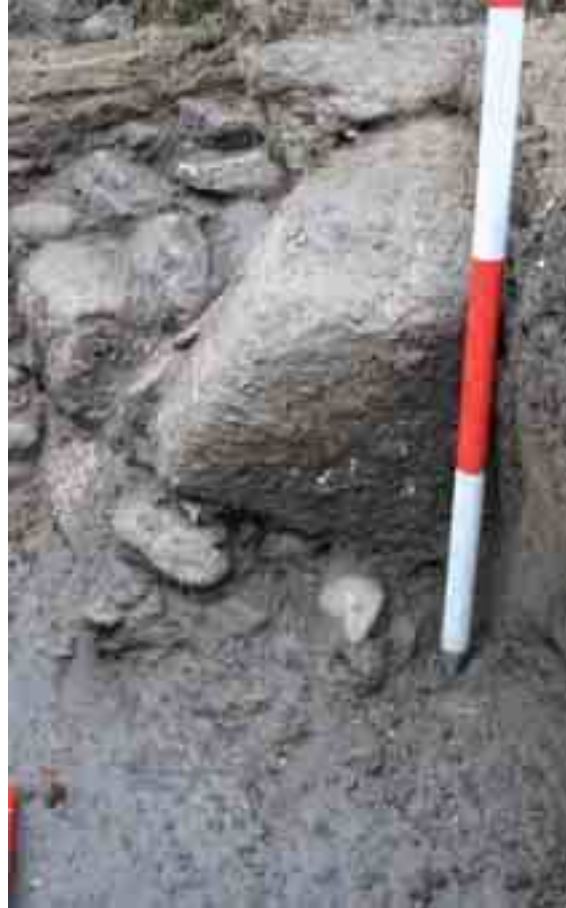
Fig. 124. Detalle de la zapata de cimentación (SII/U.E. 15).
