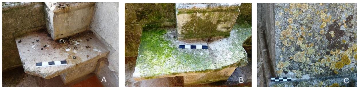
Figura 6.15 - Imagens das principais formas de degradação existentes: depósitos superficiais (A) e colonização biológica (B e C).
