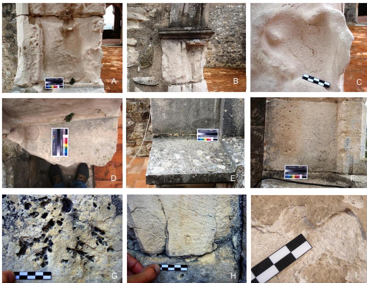
Figura 6.14 – Imagens das principais formas de degradação existentes: desagregação granular e esfoliação (A,B,C e D), colonização biológica e biofilmes (B e E), alveolização (F), perfurações (G), fissuras (H) e crostas (I).
