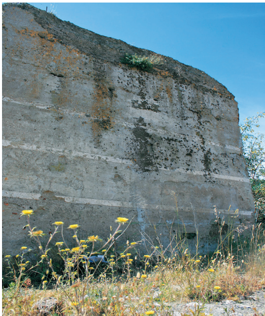
FIG. 5. Fachada norte da Torre 13
