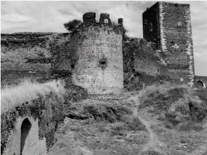
Fig. 2 – Torre sudeste do castelo de Portel coberta de revestimento, junto à torre de menagem (1966)
