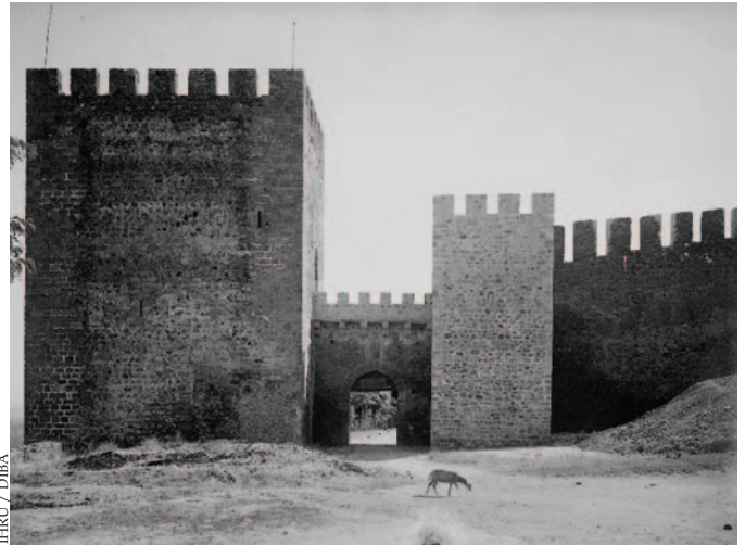
Fig. 3 – Torre de menagem do castelo de Elvas vista de Oeste, com escassos vestígios do revestimento (1941)
