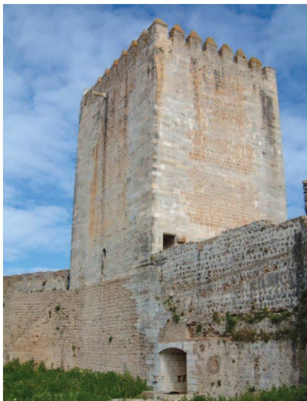
Fig. 1 - Interior da alcáçova de Moura, vendo-se à direita da porta da vila o revestimento e à esquerda a sua ausência, determinada por obras de restauro
