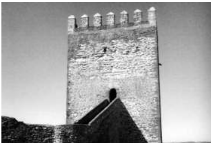
(Torre de menagem do castelo de Noudar)
