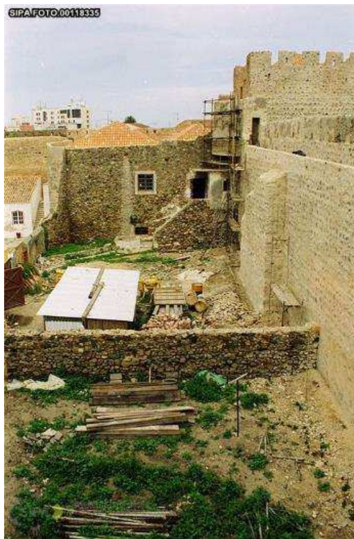
Fig. 21: Obras de recuperação da muralha e o muro identificado na S2. SIPA Foto00118335. In www.monumentos.pt
