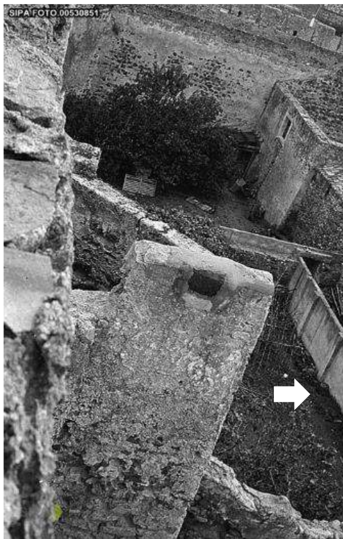
Fig. 34: Foto do Quintalão, provavelmente dos Anos 60 do século XX, onde se observa o muro identificado na S4. SIPA Foto 00530851. In www.monumentos.pt
