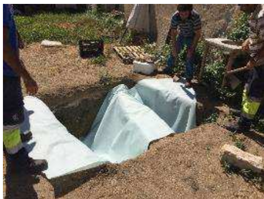
Fig. 49: Aplicação de geotêxtil na S4
