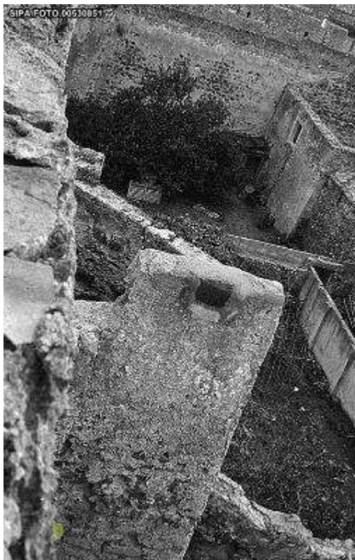
Fig. 7: Imagem SIPA Foto 00530851. 1966. In www.monumentos.pt . Observa-se no local da Sondagem 1 uma amoreira.
