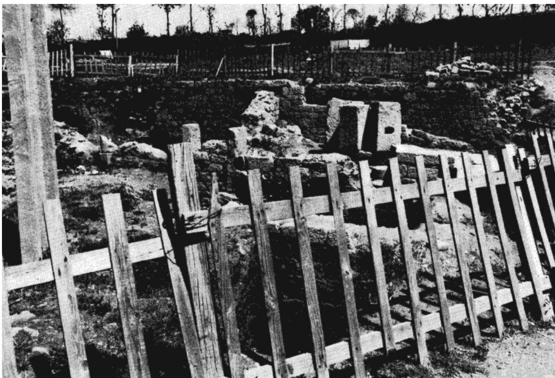
Figura 25 – Aspecto geral das ruínas da Casa do Poço 716
