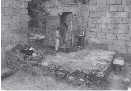
Fig. 19 – Vista geral dos trabalhos na construção anexa à torre de menagem.
