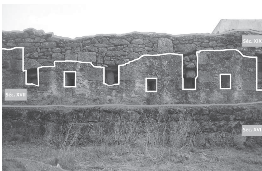
Fig. 18 – Interpretação esquemática das 3 fases de construção da barbacã, vistas pelo interior, na parte sul do castelo.
