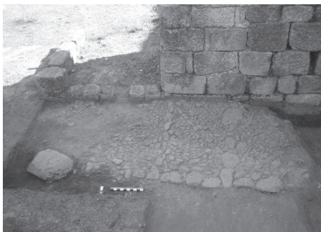
Fig. 21 – Restos da calçada seiscentista descoberta à entrada do recinto interior.
