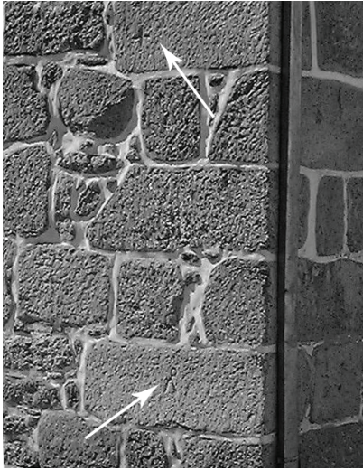
Fig. 9 – Marcas de canteiro em edifício do largo da igreja.
