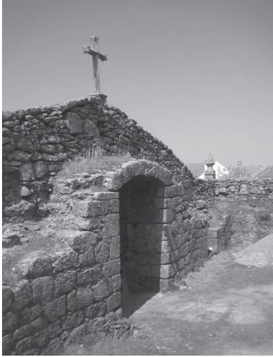
Fig. 12 – Porta principal do castelo, vista do interior.
