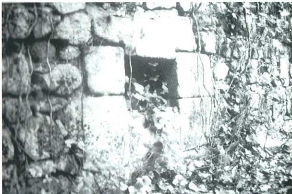
Fig. 3. Pormenor do aparelho do postigo existente na muralha
