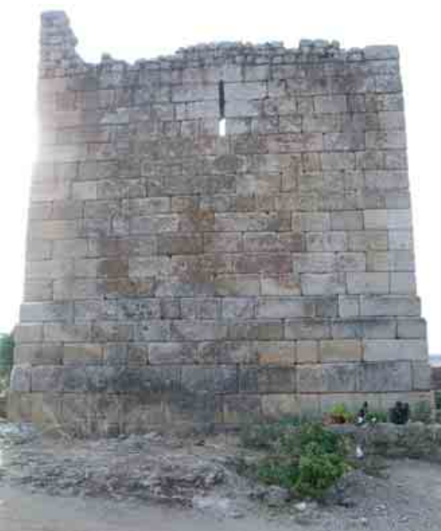
Fig. 13. Alzado de la torre medieval sobre el podium del edificio altoimperial.
