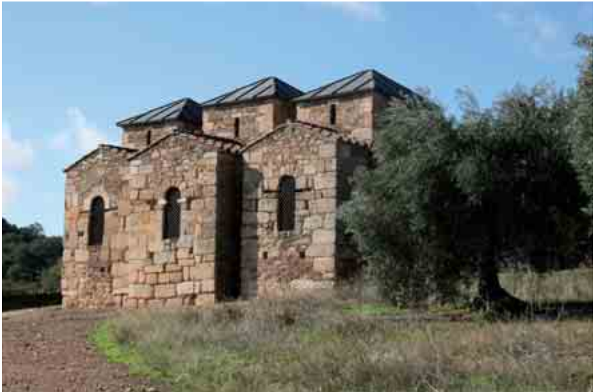
Fig. 176. Iglesia de Santa Lucía del Trampal.
