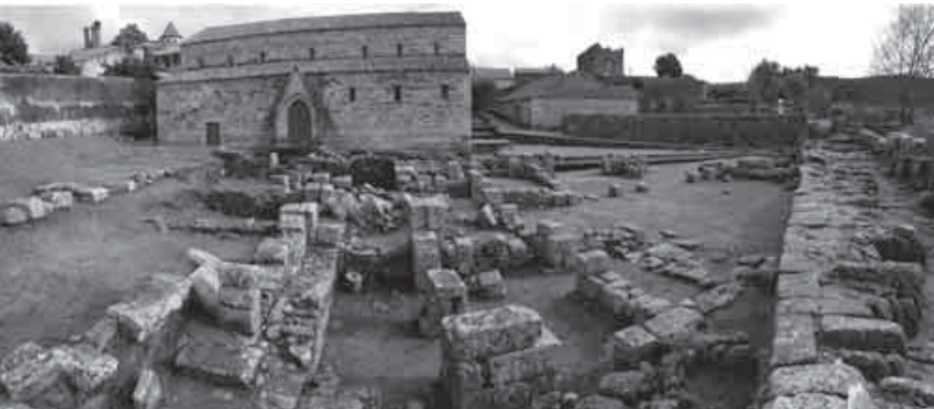
Fig. 6. Vista general actual de las estructuras documentadas entre la muralla bajoimperial y la Sé-Catedral de Idanha-a-Velha.
