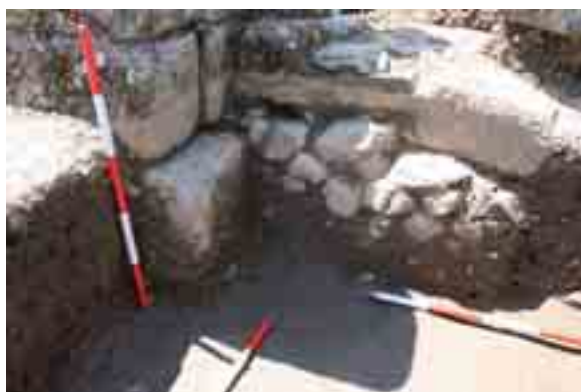
Fig. 161. Detalle de la zapata de cimentación del pilar anterior.
