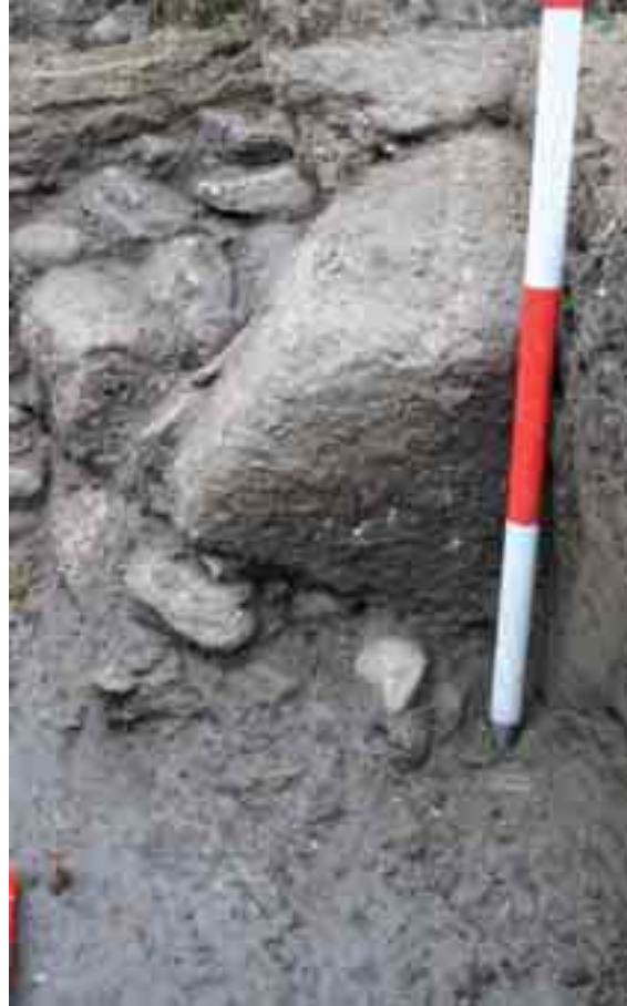
Fig. 124. Detalle de la zapata de cimentación (SII/U.E. 15).
