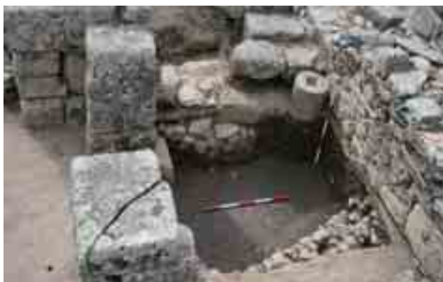
Fig. 129. Primer tramo identificado del intercolumnio de la nave central.
