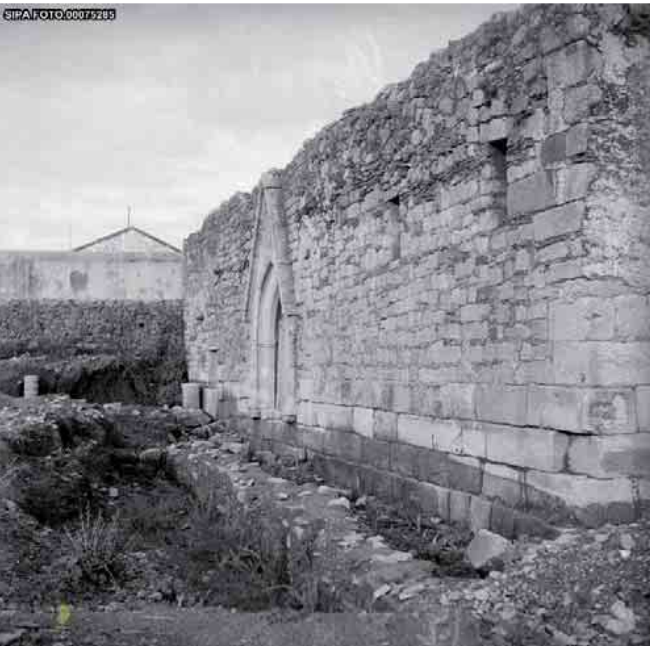
Fig. 22. Fachada de la iglesia en 1959 (©SIPA).
