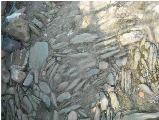
**FIGURA 49 – TROÇO DE PAVIMENTO DE XISTO A CUTELO EXISTENTE NO LOCAL
