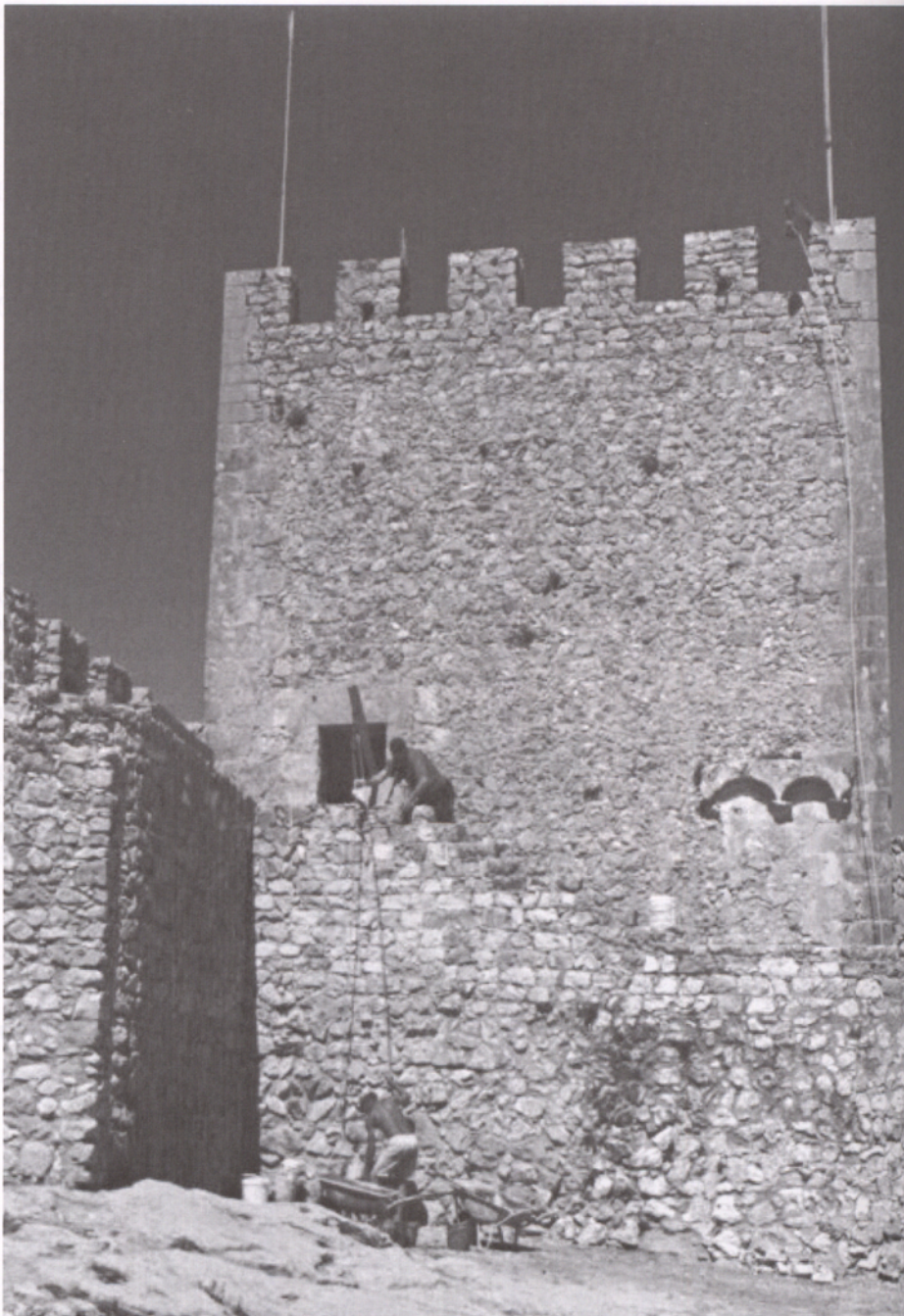
Fig. 3 – Obras de conservação da Torre de Menagem, promovidas pela D.G.E.M.N. (Foto do Fundo documental do Museu Municipal de Sesimbra).
