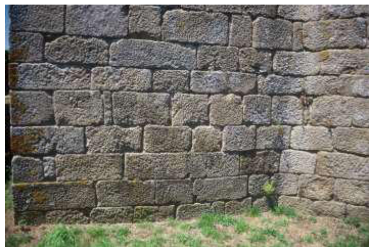
Pormenores da cisterna, porta sul e aparelho do cubelo nascente da fortificação medieval de Lindoso
