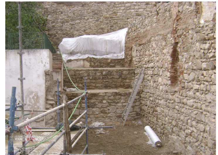
Fig. 19 - Estrutura de contenção e cobertura da muralha de taipa
