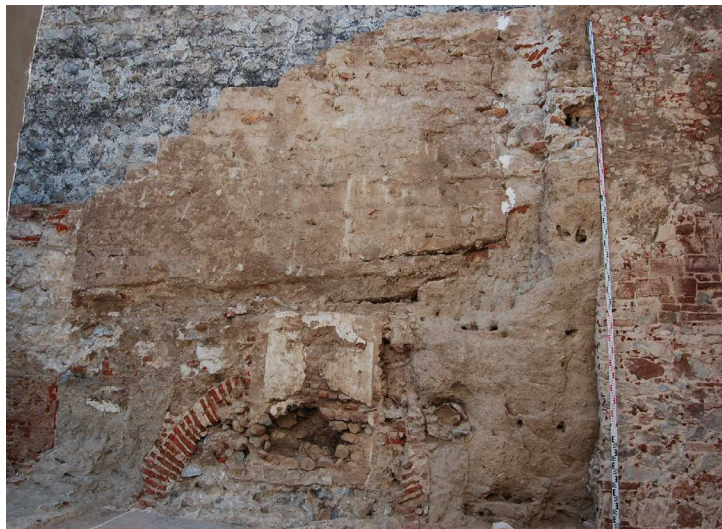
Fig. 6 - Muralha de taipa, com os negativos de "agulhas", identificada na sala 5 da Casa do Governador
