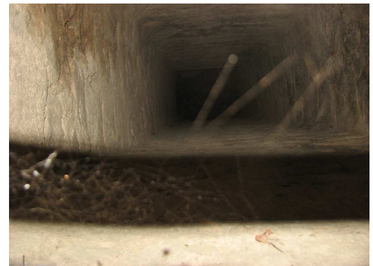
Fig. 12 - Poço vertical quadrangular sob arco
