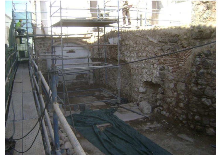
Fig. 18 - Muralha manuelina após demolição do n.º 29-33, da Rua da Barbacã
