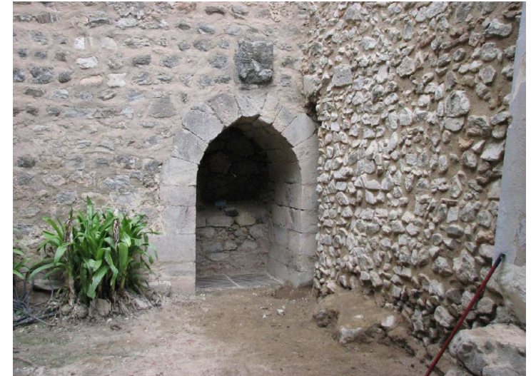
Fig. 11 - Arco encabeçado por um brasão muito danificado e sob o qual se verifica um poço vertical, na muralha oeste da alcáçova
