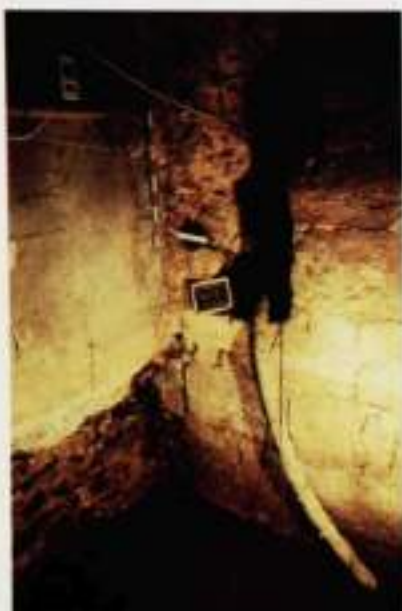
Fig. 1- Interior da Casa dos Bicos em 1962: Face este de torre quadrangular da Cerca Moura, vendo-se o nível freático.
