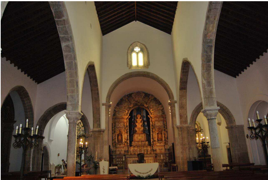
Fig.7 – Interior da Igreja de S. Clemente, com cobertura de madeira e vigamento à vista Fonte: Vanda Pereira 2012
