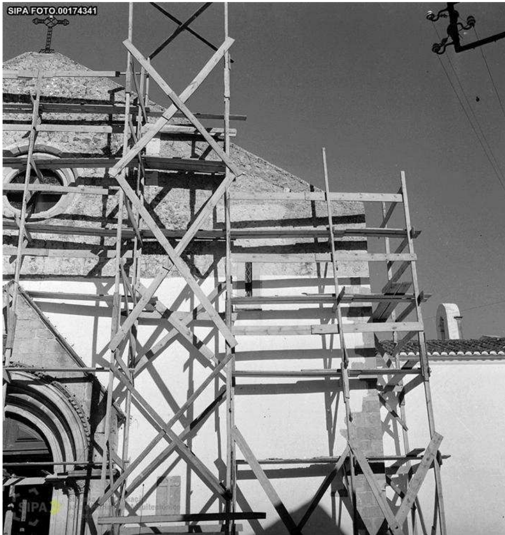
Fig.36 – Fachada principal de S. Clemente em obras em 1970 Fonte: SIPA
