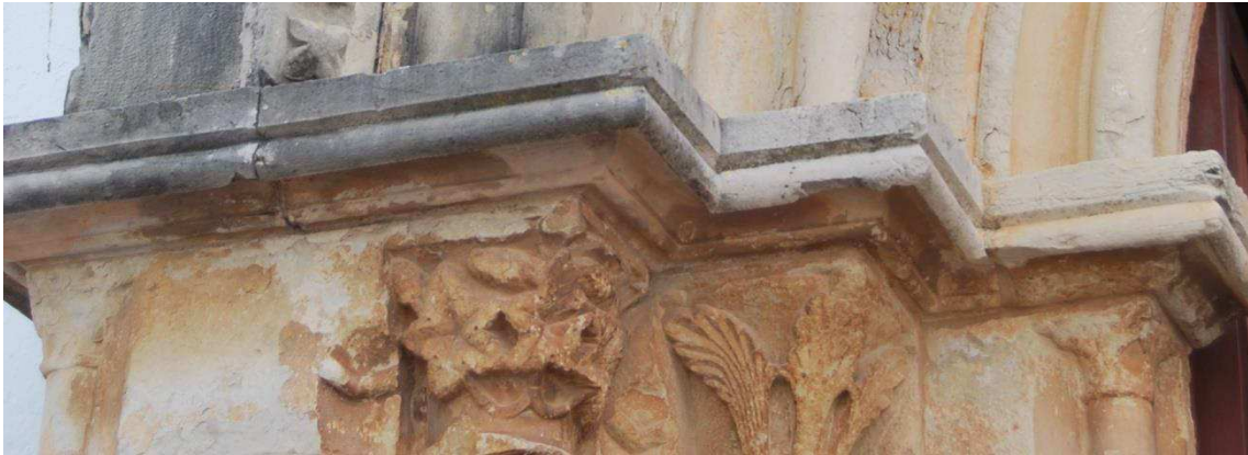
Fig.16 - Capitéis das colunas e dos colunelos do lado esquerdo do portal axial, com decoração vegetalista, já muito degradada Fonte: Vanda Pereira 2012
