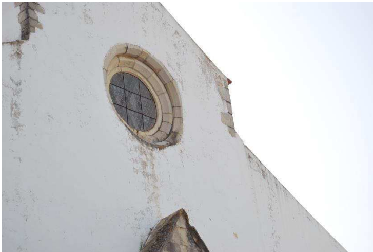
Fig.12 - Óculo da Igreja de S. Clemente Fonte: Vanda Pereira 2012
