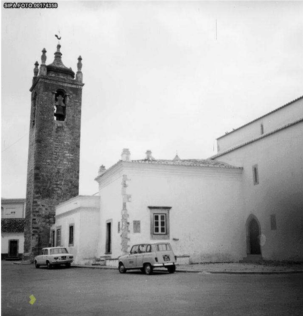
Fig.28 - Vista Lateral esquerda da Igreja de S. Clemente de 1973 (depois da conclusão da campanha de obras) Fonte: SIPA
