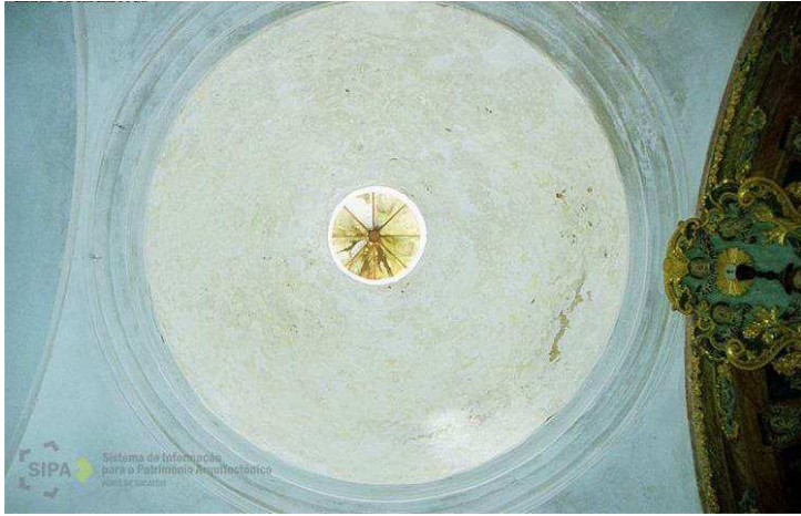
Fig Fig.8, 9 e 10 – Coberturas da cabeceira da Igreja de S. Clemente: Capela lateral esquerda – cúpula; Capela-mor – abóbada de berço; Capela lateral direita abóbada artesoada Fonte: Vanda Pereira 2012
