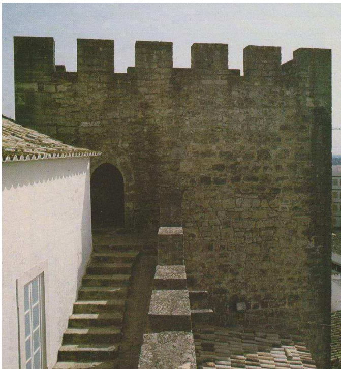
Fig.2 - Torre rectangular construída sobre a muralha Fonte: Isilda Pires Martins, José Luís de Matos, Muralhas de Loulé , Loulé, Câmara Municipal de Loulé, 1986
