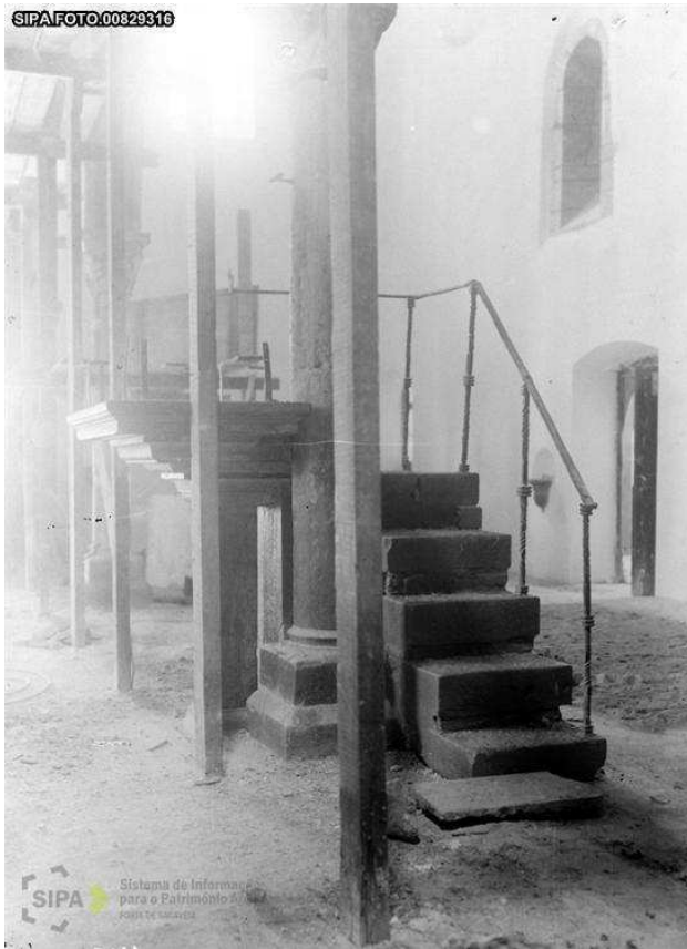
Fig.33 – Interior da igreja em obras, que datam de 1941 Fonte: SIPA
