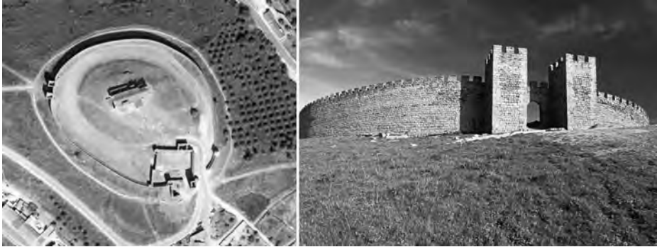
Fig. 31 Arraiolos: vista aérea e porta flanqueada por cubelos
