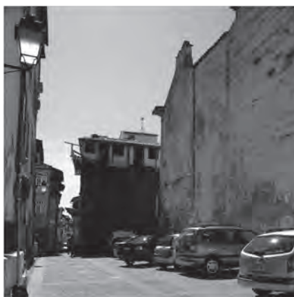
Fig. 6 Fotografia da área correspondente ao edifício demolido
