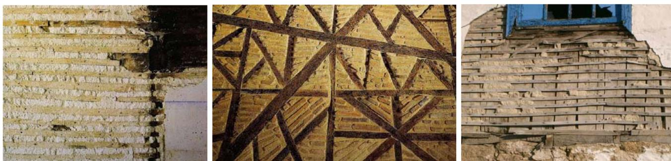
Fig. 78, 79 e 80 - Paredes de alvenaria de taipa de: fasquio, de rodízio e de tabique
