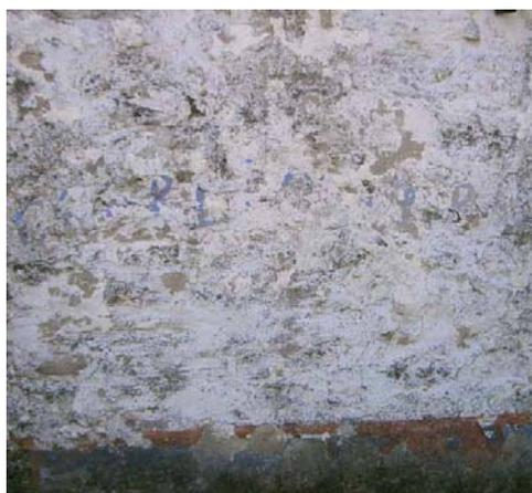
Fig. 73 - Uma das poucas paredes com reboco de cal existentes em Penedono
