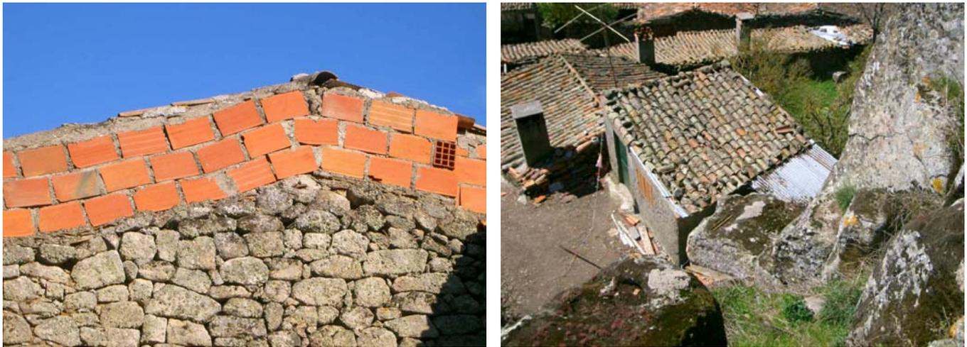
Fig. 56 e 57 - Exemplos de utilização de materiais de construção dissonantes em edifícios tradicionais
